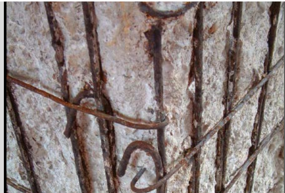
Foto 2 Ejemplo de deterioro en refuerzo de concreto por causa de la corrosión
