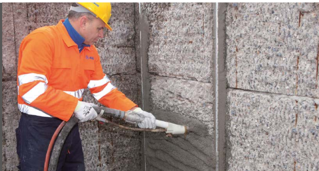
Foto 6 Aplicación de MAPEGROUT 430 proyectado, Mortero estructural clase R3 en una estructura de concreto
