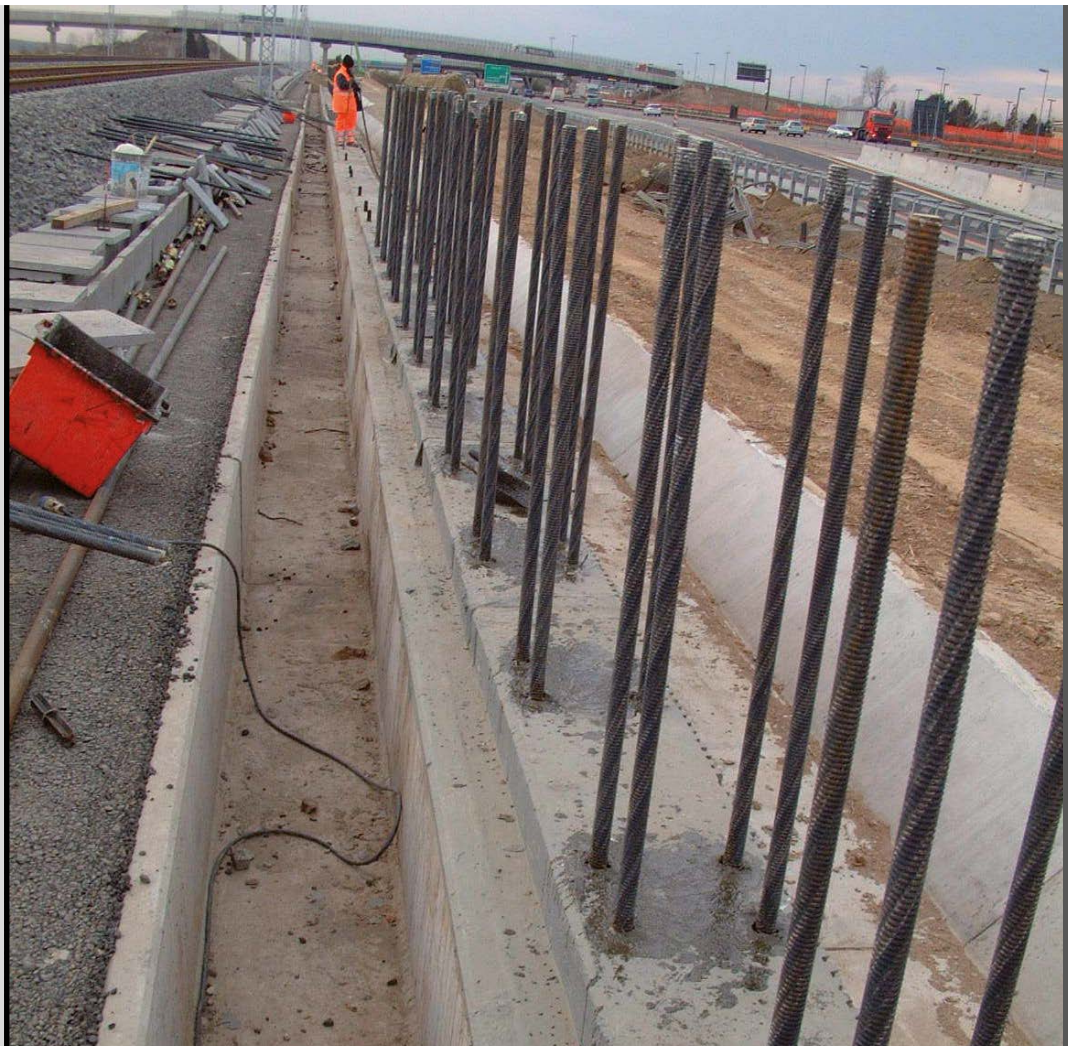
Foto 12 Anclaje de barras de acero en concreto usando PLANIGROUT 300
