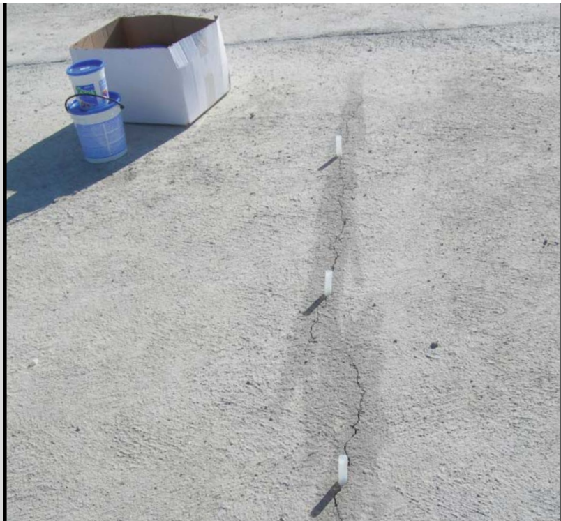
Foto 11 Inyectando EPOJET en una losa de concreto fisurada
